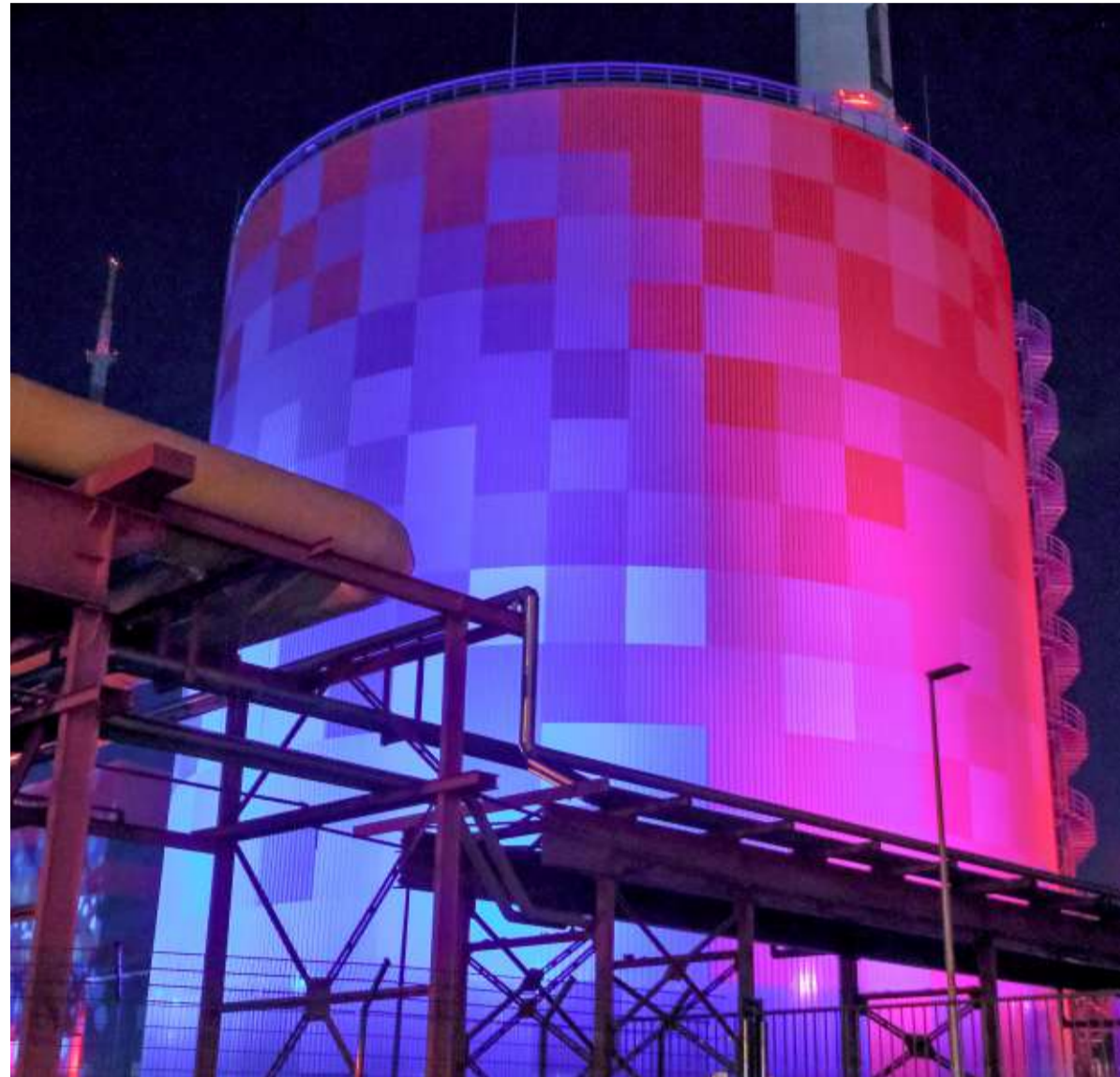
Die EVH setzt auf Nachhaltigkeit und nicht nur auf Gas. Die größte „Thermoskanne“ der Welt „bunkert“ warmes Wasser, das zuvor mit überschüssigem Strom aus erneuerbaren Energiequellen erhitzt wurde. Je nach Bedarf fließt es dann in die Versorgung der Kunden mit Fernwärme - zeitlich entkoppelt von der Stromproduktion.
