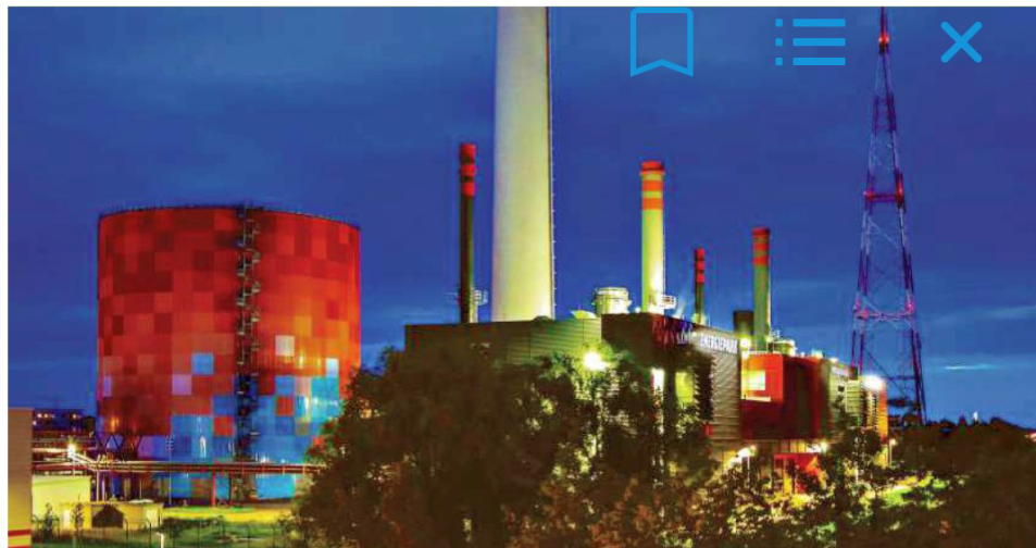
Das Herz der Energie- und Wärmeversorgung in Halle schlägt im Energiepark an der Dieselstraße. Der gigantische Wärmespeicher (links) ist nicht nur ein Hingucker. Er ist so gewaltig, dass er ausreichen würde, die Fernwärmekunden in Halle drei Tage zu versorgen. Bei kurzfristigen Engpässen ist das Gold wert. FOTO: STADTWERKE
